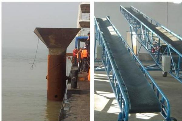
图6 导管抛投法的主要结构
